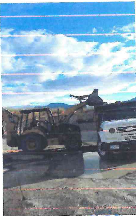
TERRACERIAS: Carga por medios mecanicos y acarreo en camion volteo de materiales sobrante de excavaciones a primer kilometro y tres kilometros subsiguientes en zona sub-urbana y carretera, incluye: la mano de obra, herramienta, maquinaria y el equipo necesario.
