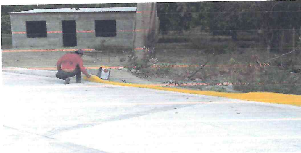
PINTURA EN GUARNICIONES. Pintura en guarnición por medios manuales con pintura a base de resinas alquídicas color amarillo, incluye: materiales, mano de obra, limpieza y herramientas.
