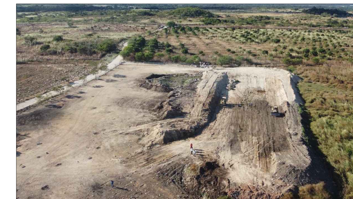
Imagen 2.- Vista general centro de acopio
