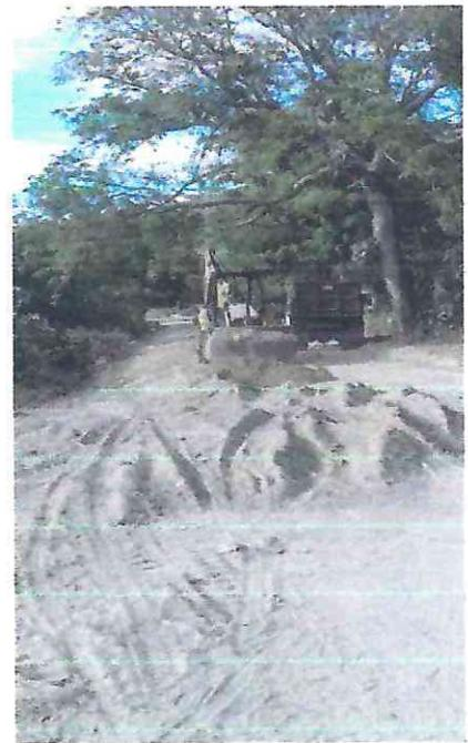
TERRACERIAS. Excavacion por medios mecanicos para formacion de caja en terreno seco en material II, incluye: apile del material para su posterior carga y retirado, operación y consumibles.
