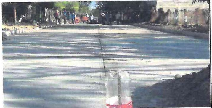
PAVIMENTO HIDRAULICO. Pavimento de concreto hidraulico de 15 cms de espesor, fraguado normal, resistencia  $f_c=250$  kg/cm<sup>2</sup>, hecho en obra, incluye: cimbra en fronteras, fabricación, vaciado, tendido y pulido del concreto con acabado rayado con peine metalico, descimbrado, cortes con disco a 1/3 de espesor para juntas de contracción, curado, descimbra, herramientas y mano de obra
