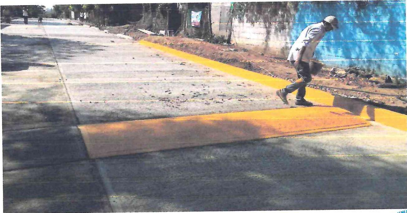
PINTURA EN GUARNICIONES. Pintura en guarnicion por medios manuales con pintura a base de resinas alquidolicas color amarillo, incluye: materiales, mano de obra, limpieza y herramientas.
