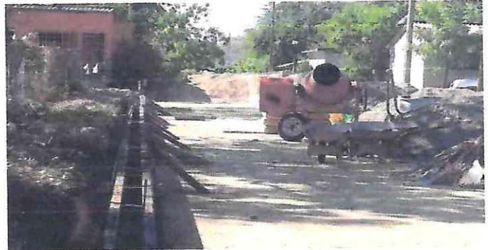
GUARNICIONES: Guarnición de 15x20x40 cms de sección trapezoidal, fraguado normal de resistencia  $f'c=200$  kg/cm<sup>2</sup> hecho en obra, con agregado máximo de 3/4" incluye: cimbra metálica, elaboración y vaciado del concreto, aristas con acabado de volteador, corte, vibrado, descimbrado, curado, herramientas y mano de obra.
